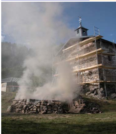
Cuisson du plâtre pour réalisation de l'enduits extérieurs
