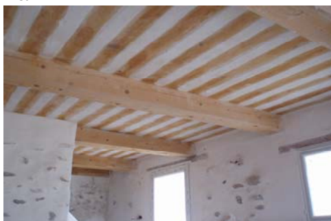
Plancher en plâtre traditionnel
